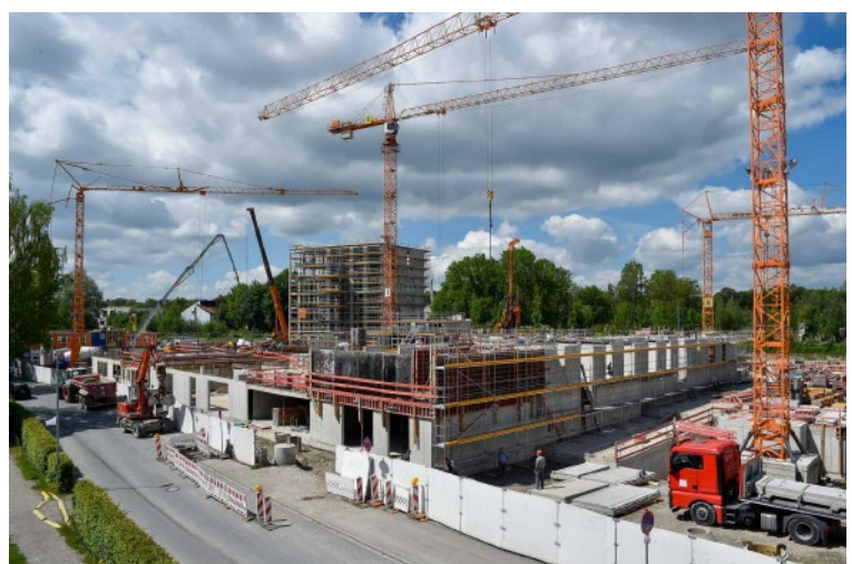
Baustelle im Mai 2020
